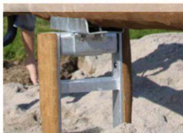
La quincaillerie est en acier inoxydable ou galvanisé afin de garantir la longue durée de vie des raccords et leur excellente résistance à la corrosion.
